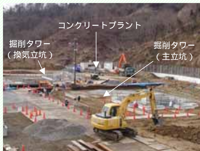
地上設備の基礎工事の様子
